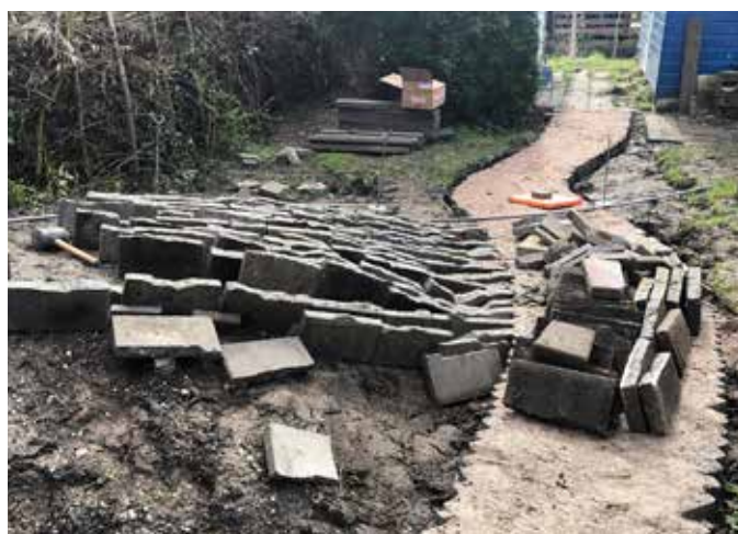
Tijdens de aanleg
